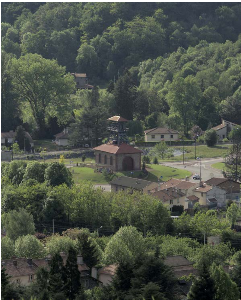
Puits du Marais © DR
